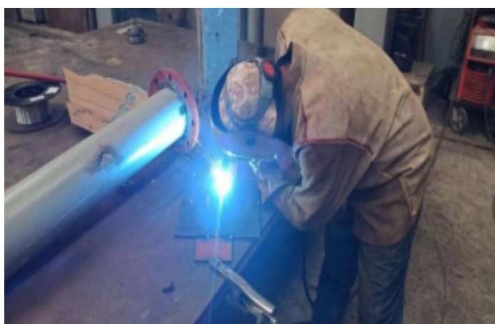
Figura 4. Inicio del proceso de soldadura.
